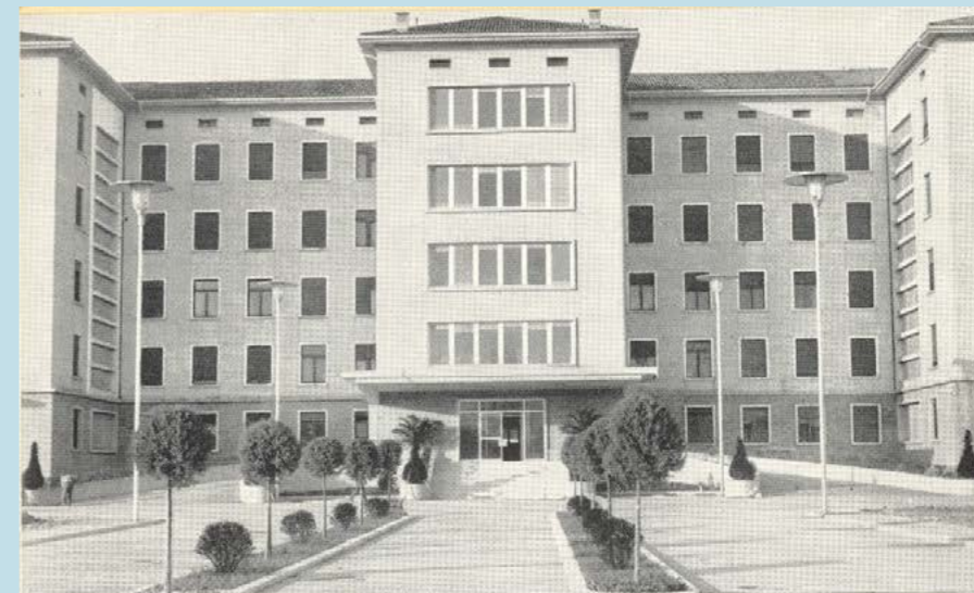
Scorcio dell'ingresso principale
