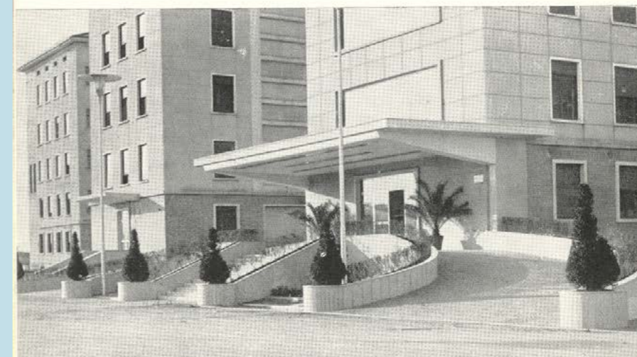
La rampa di accesso all'ingresso principale
